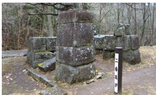
橋野鉄鉱山の高炉跡
