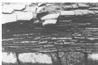
図10 穴太廃寺再建金堂平積式瓦積基壇
