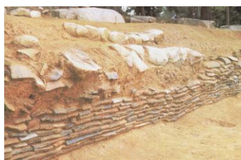
図10 穴太廃寺再建金堂平積式瓦積基壇
