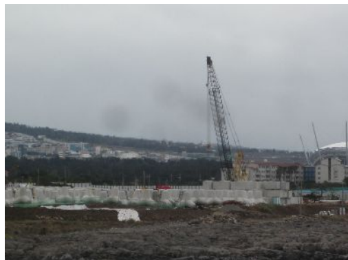
工事が一部始まっている
